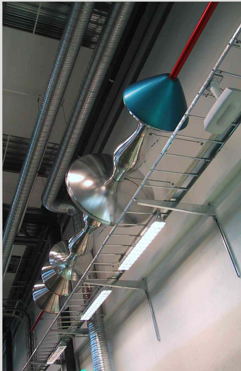
Doppler på röd linje detaljbilder Aluminium. Längd 120 meter, maxdiameter 1,32 meter. Nybodadepån; reparationshall för tunnelbanetåg, Hägersten 2002
